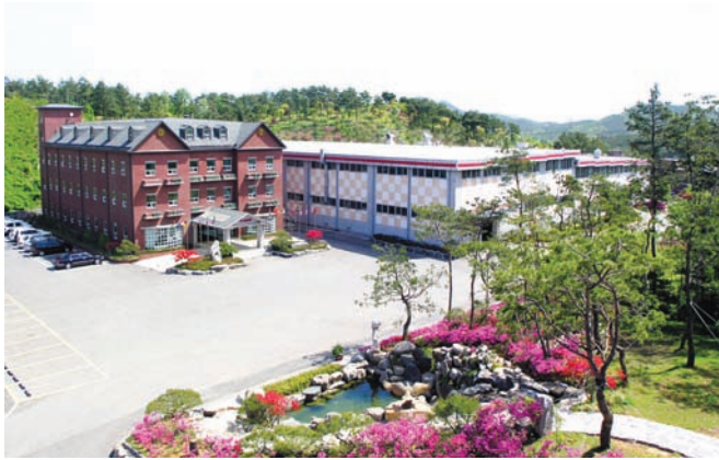
Head Office & Cyber Factory 본사 / 공장
